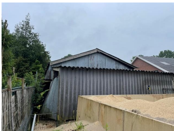
Foto 5: links, achterkant en zijkant kleine deel van de schuur.
