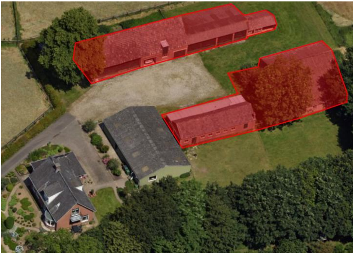
Figuur 9: Het erf met de te slopen opstallen en te kappen bomen en struiken in rood gemarkeerd
