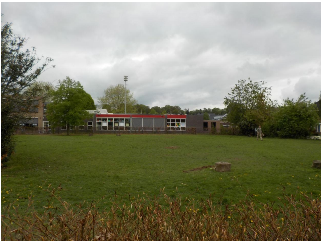
Afbeelding 14: Impressie van de onderzoekslocatie. Foto genomen in westelijke richting.
