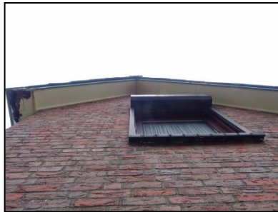
Figuur 11. Onderaanzicht van de gootbetimmering met overhangende kantpannen.
