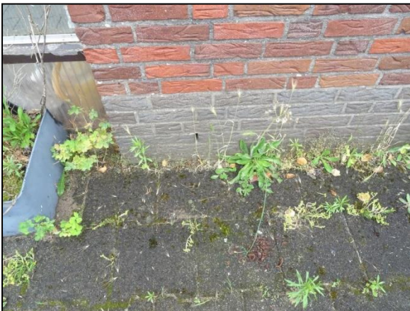
Figuur 19. Enkele ongeschikte stootvoegen (te laag bij de grond).
