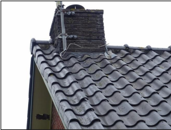
Figuur 17. Ruimte bij de schoorsteen, de nok en de hangende kantpannen voor in- en uitvliegende vleermuizen.
