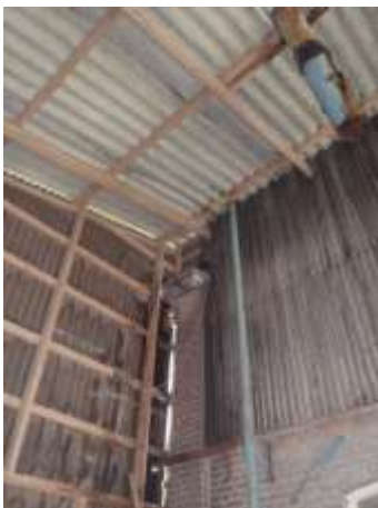
Foto 14: binnenzijde van de overkapping onder de silo in het gebouw Wehlseweg 19.
