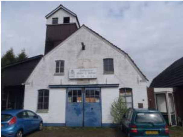
Foto 7: Wehlseweg 19 buitenzijde de silo die dor het dak is aangebracht steekt boven het dak uit. De pannen zijn met cement afgedicht.
