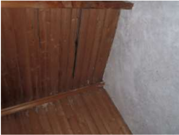
Foto 1: dakbeschot Wehlseweg 21, de topgevel van de achterzijde is hier zichtbaar.
