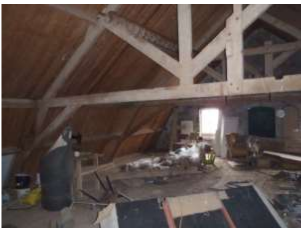
Foto 9: de zolder van Wehlseweg 19 met de beschoten mansarde kap.
