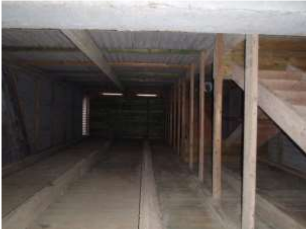
Foto 10: Binnenzijde van de schuur met silo en naastgelegen trap. Bovenaan de foto is de buitenwand zichtbaar onderaan de foto de houten silo.
