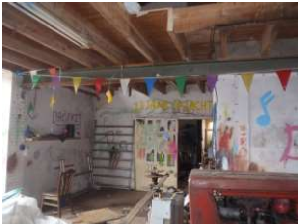
Foto 6: deel achter de werkplaats met het plafond. Hier ontbreekt een plafond. Door de open deur is de voorgelegen ruimte nog zichtbaar.
