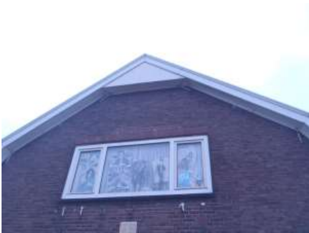
Foto 3: topgevel Wehlseweg 21 met daktrim en betimmering. De betimmeringen verkeren in een goede staat zonder kieren of spleten.
