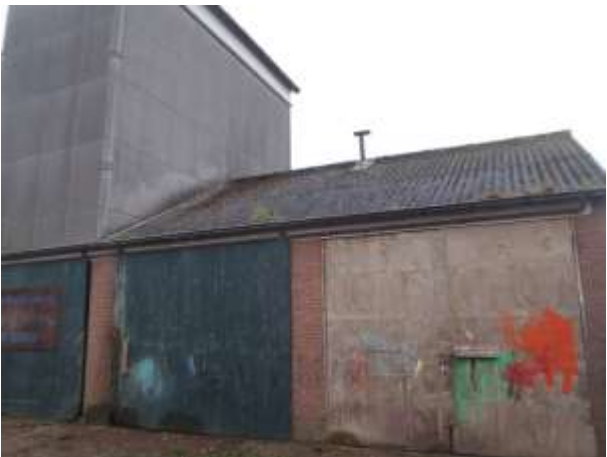
Foto 12: laatste schuur waarvan de scheidingsmuur is doorgebroken.
