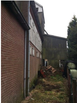
Figuur 8: Dak(goot) bebouwing
