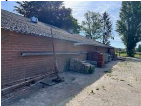
Figuur 14: Dak(goot) bebouwing
