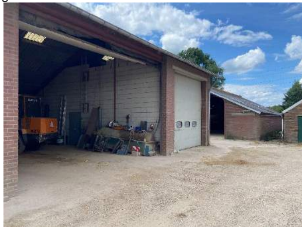
Figuur 14: Bovengrondse dieseltank (buiten gebruik)
