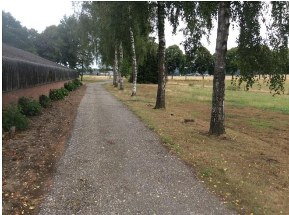
Figuur 8: Overzichtsfoto bebouwing
