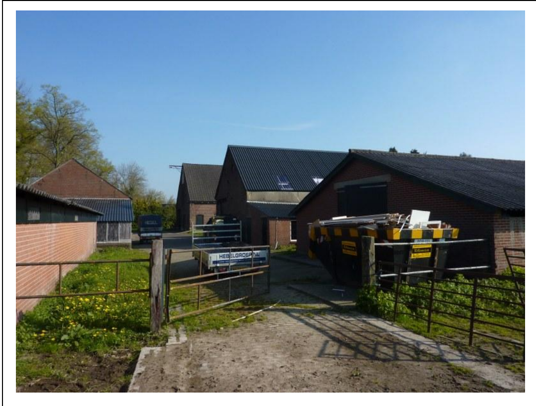
Foto 1. Overzicht voormalige stalruimtes
