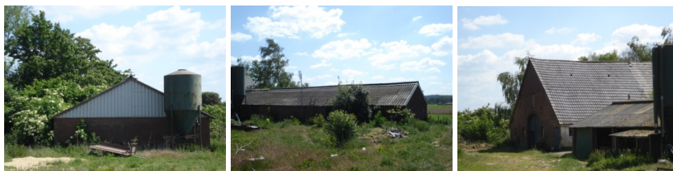
Foto's: De te slopen opstallen.
