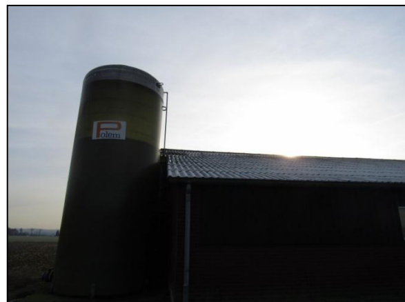
Figuur 8. Golfplaten op het dak.
