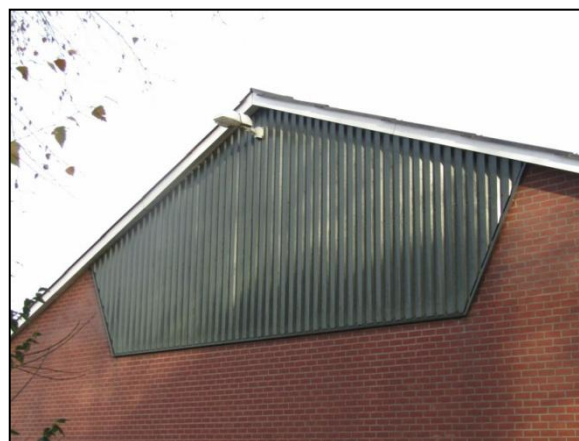
Figuur 7. Geen geschikte openingen bij de nok van de varkensstal.
