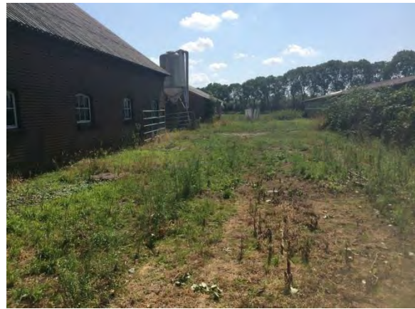
Figuur 9: Asbestverdachte dakbedekking
