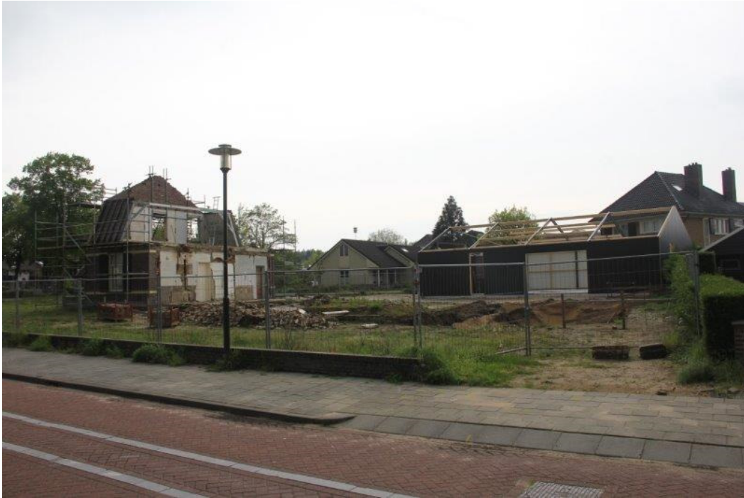
Aanzicht vanaf de Oude Doetinchemseweg, met inmiddels een gedeeltelijk opgebouwde bijbouw rechts achter het te verbouwen pand.
