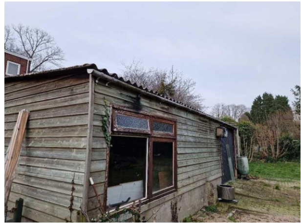
Figuur 12: Schuur achterliggend terrein
