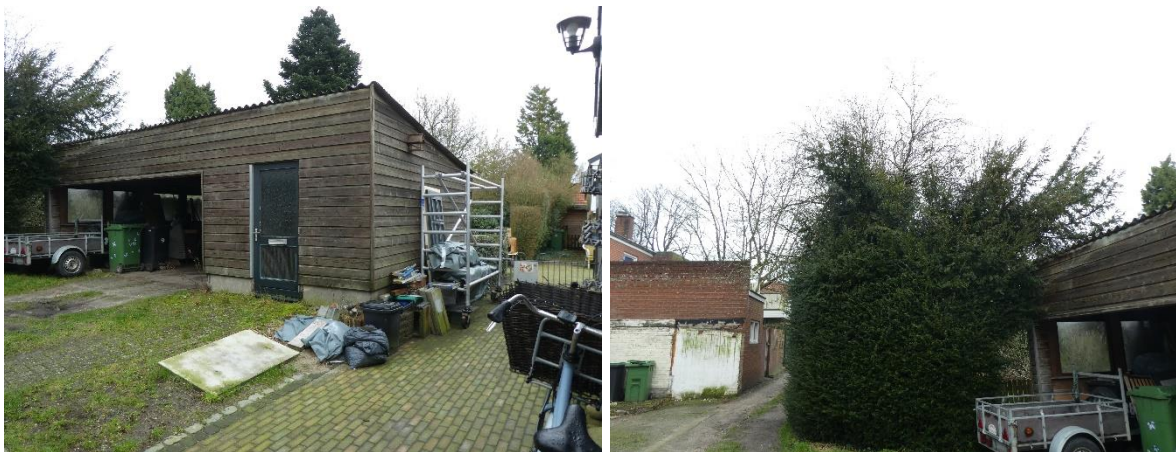
Afbeelding 3 t/m 8: de te slopen bebouwing. Bron: BNL advies. Datum: 10-03-2023 en 7-2-2024
