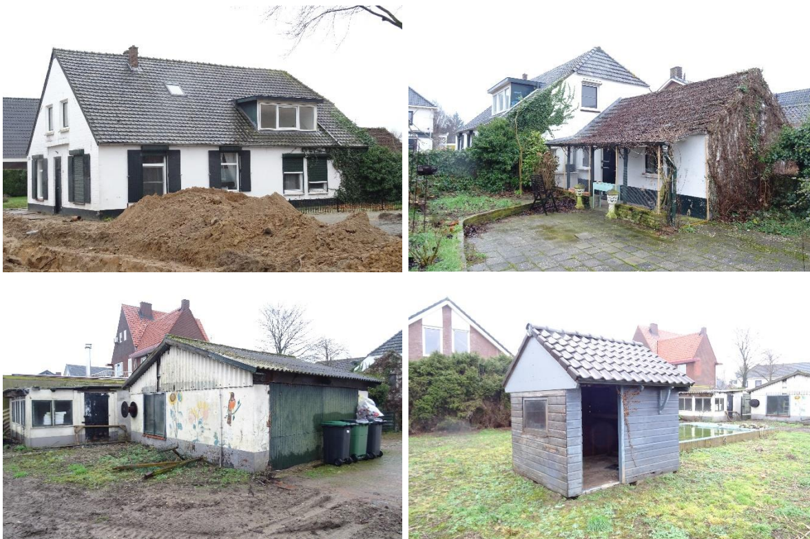
Afbeelding 3 t/m 6: De te slopen woning en bijgebouwen. Bron: BNL advies. Datum: 01-02-2022
