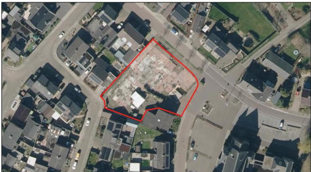
Afbeelding 2.1 Luchtfoto huidige situatie Wehlseweg 34, Loil (Bron: PDOK bewerkt)
