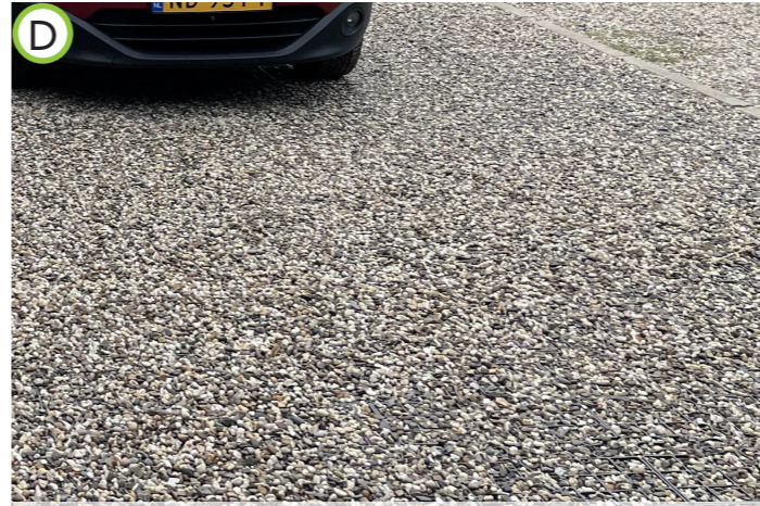
Oprit van halfverharding, grotendeels bestaand.
