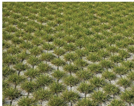
Grasbeton voor waterdoorlaatbaarheid
