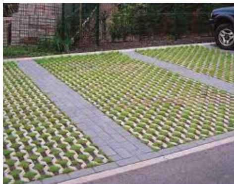
Parkeren op grasbeton
