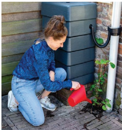
Regentonnen voor eigen wateropslag
