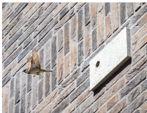
Geïntegreerde nestkasten voor vogels in gevels
