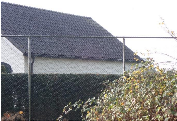
Foto 7: links, huismussen in de dakgoot in het westen van het plangebied.
