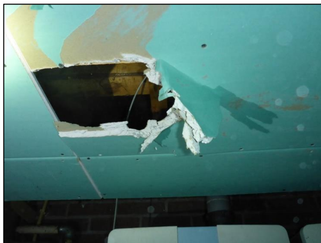
Foto 20: CV-ruimte: Plafondafwerking (Niet asbestverdacht)
