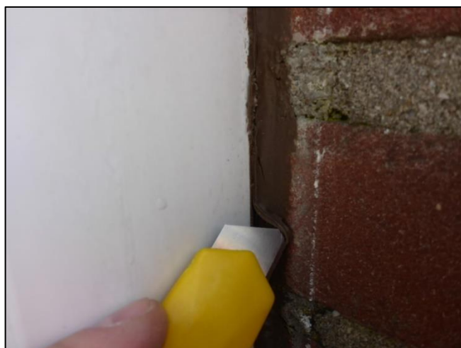
Foto 6: Kit langs raamkozijn (Niet asbestverdacht)
