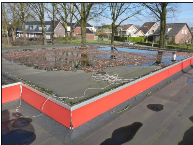
Foto 3: Dak: Boeidelen (Niet asbestverdacht)
