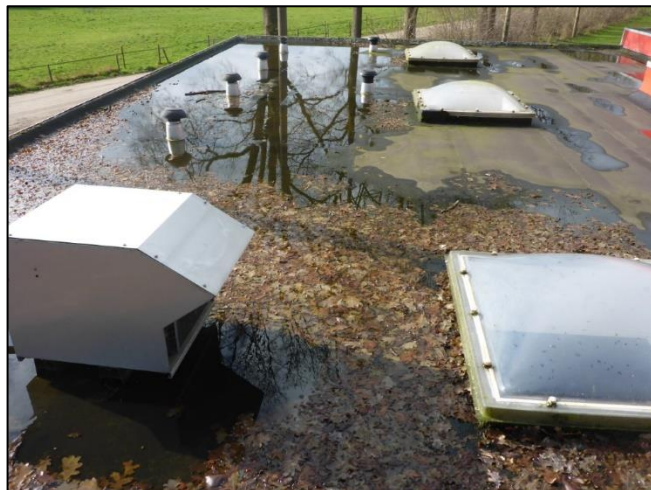
Foto 2: Dak: Lichtkoepels en doorvoeren (Niet asbestverdacht)
