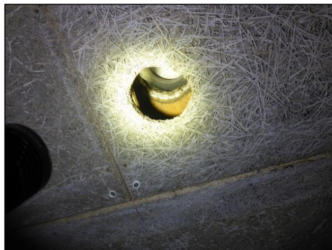
Foto 8: Binnenzijde: Plafondafwerking (Niet asbestverdacht)
