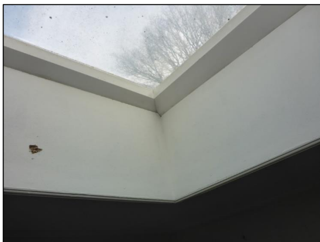
Foto 9: Lichtkoepels: Afwerking binnenzijde (Niet asbestverdacht)
