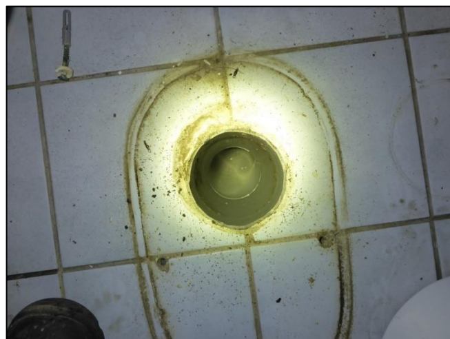
Foto 10: Toilet: Afvoerbuizen (Niet asbestverdacht)
