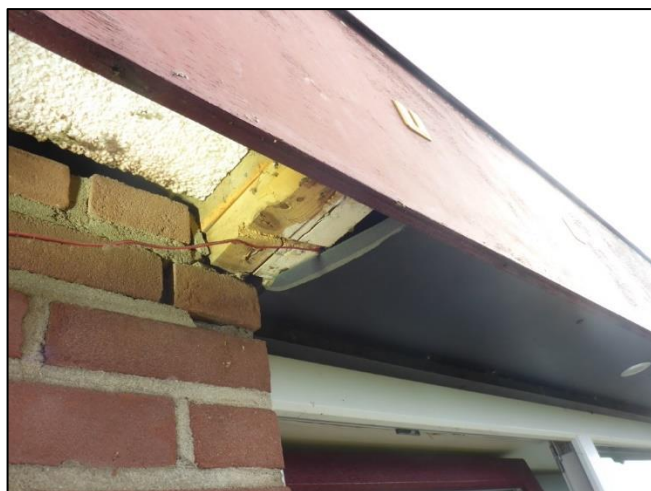
Foto 4: Dak: Overstek afwerking (Niet asbestverdacht)
