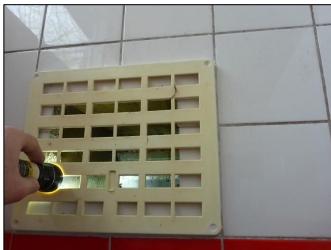
Foto 22: Kleedruimte: Ventilatie-doorvoer (Niet asbestverdacht)
