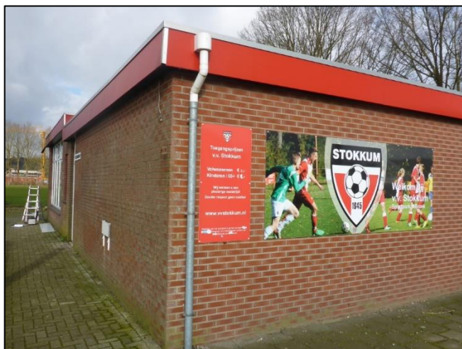
Foto 7: Buitengevels: Afwerking en hemelwaterafvoer (Niet asbestverdacht)
