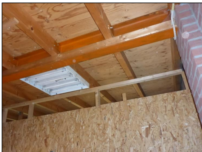
Foto 21: Opslagruimte: Plafond- en wandafwerking (Niet asbestverdacht)
