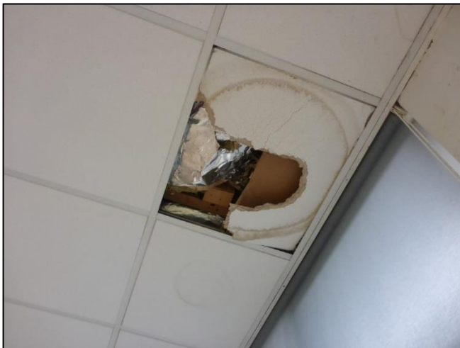
Foto 13: Kantine: Plafondafwerking (Niet asbestverdacht)
