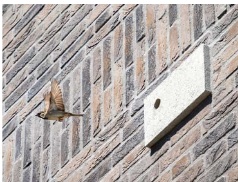
Geïntegreerde nestkasten voor vogels in gevels
