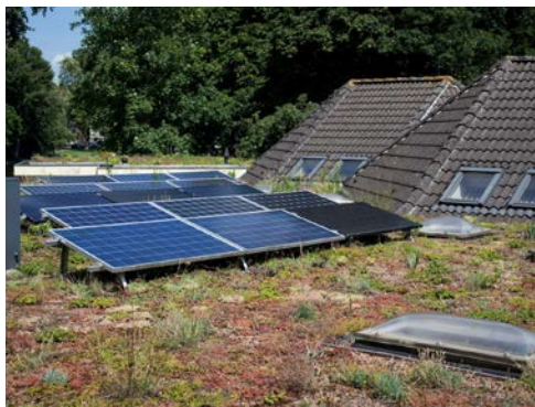
Plat dak met vegetatie en zonnepanelen
