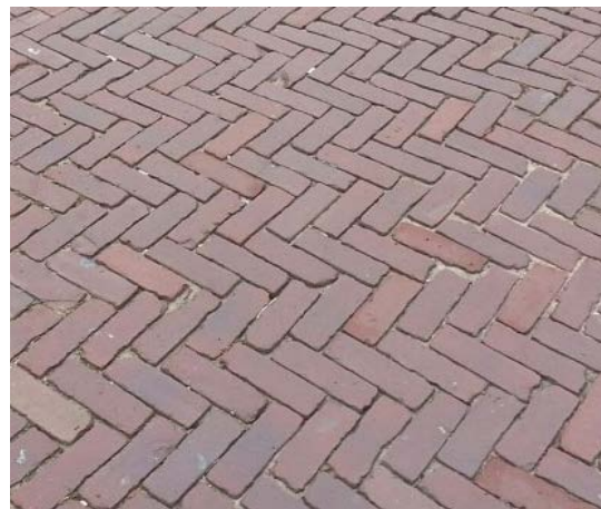
Klinkerverharding in gebakken materiaal
