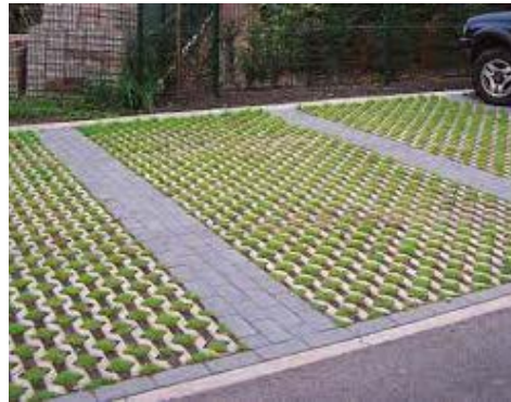
Parkeren op grasbeton
