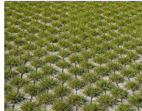
Grasbeton voor waterdoorlaatbaarheid
