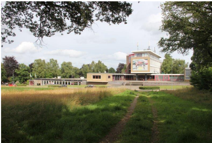
Aanzicht van de bestaande situatie vanuit het westen, vanaf de oprit naar de molen.
