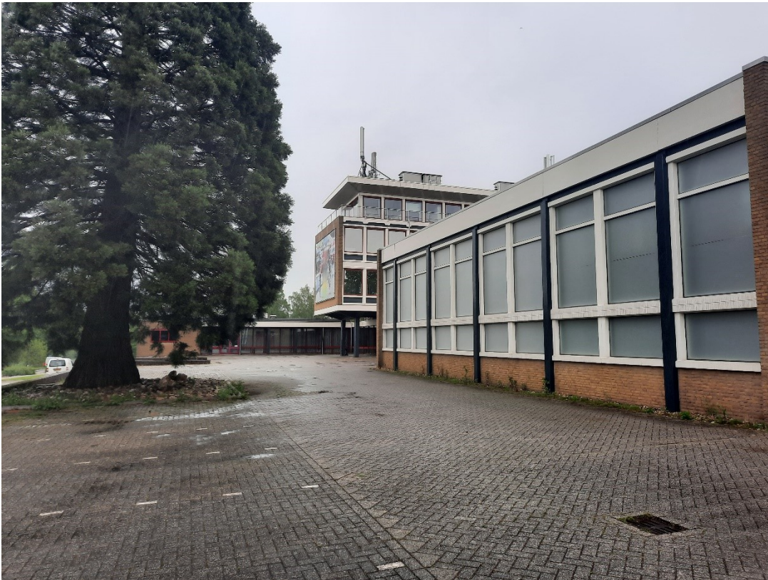
Foto 1: Voorzijde van het gebouw
