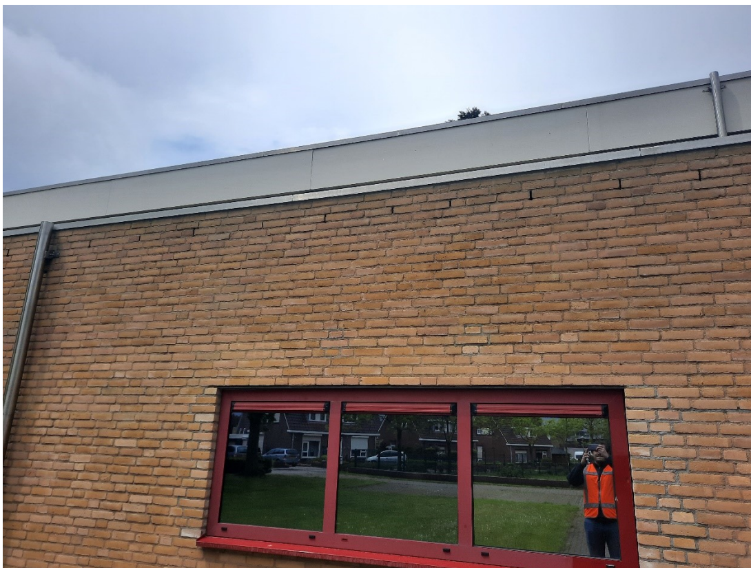
Foto 8: Stootvoegen zijn aanwezig op voldoende hoogte voor vleermuizen
