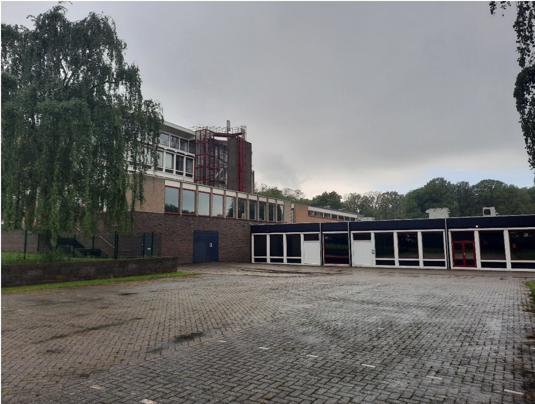
Foto 3: Achterzijde van het gebouw, inclusief parkeergelegenheden
