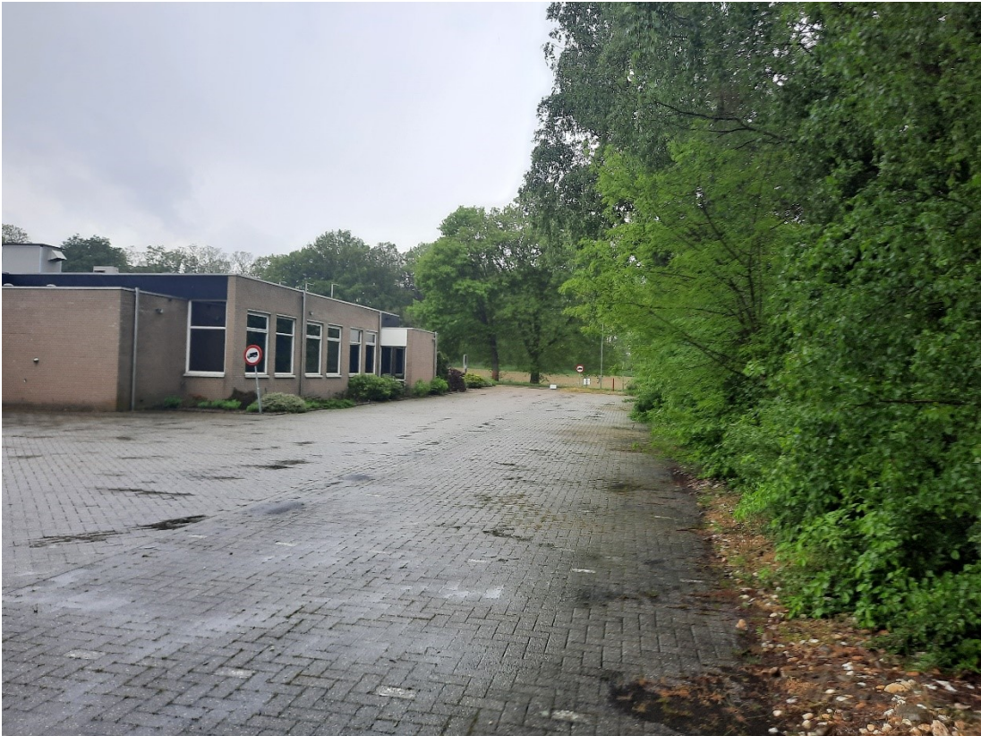
Foto 4: Linker achterzijde van het gebouw
