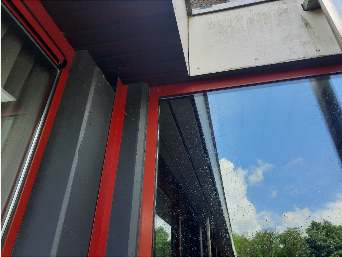
Foto 9: Kozijnen sluiten goed aan
