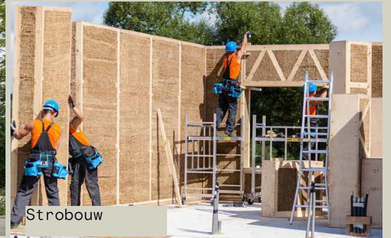
prefab kalkhennep systeem. Bureau SLA
