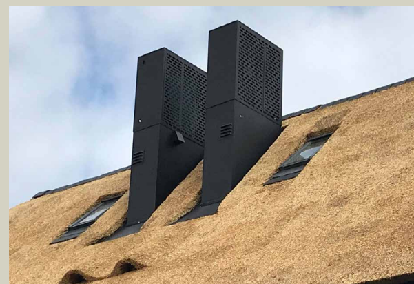
Slim: warmtepompunit (die vrij moet kunnen luchten) geïntegreerd als schoorsteen.
