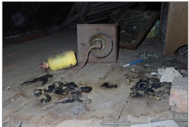
Afbeelding 3.6 | Latrine op de zolder van het woonhuis
