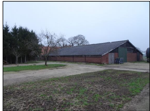
Aanzicht stal in zuidoostelijke hoek met naastliggend het kleine stakenbos;
