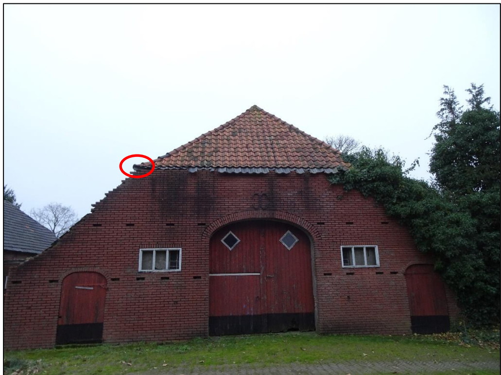
Aangetroffen potentiële nestplaatsen voor gierzwaluwen.
