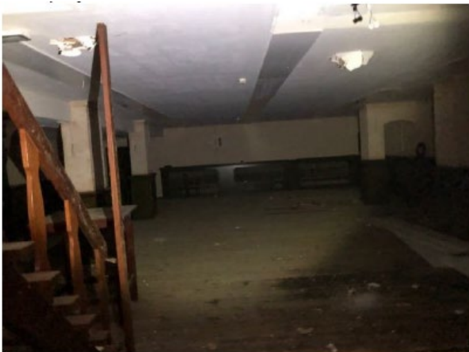
Afbeelding 3.15: Foto kelder. Bron: Demolition Management
