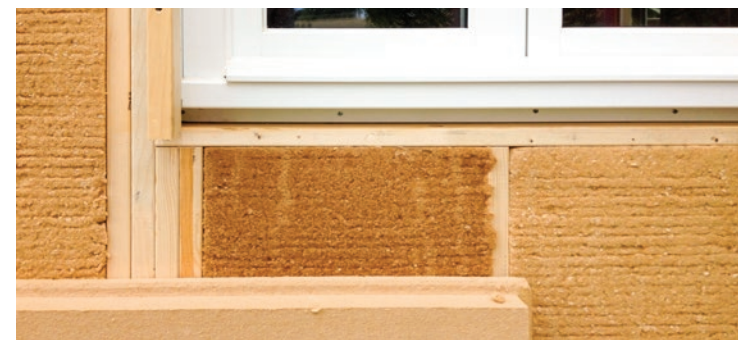
Gevelopbouw met biobased materialen
