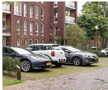
Parkeren op grasbeton
