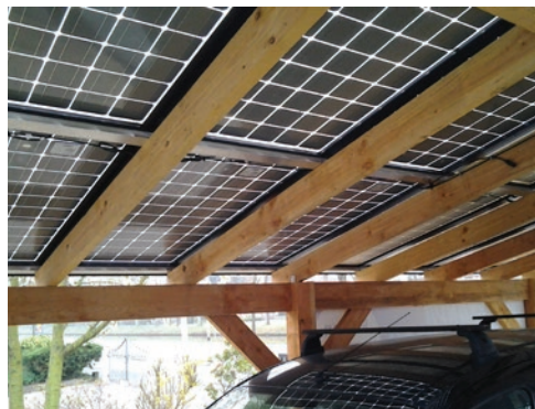
Overkapping met zonnepanelen
