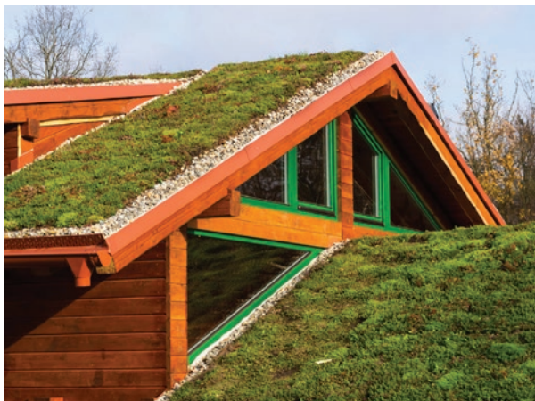
Groene daken voor waterinfiltratie op eigen kavel
