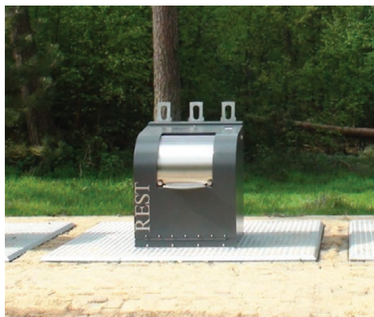
Centrale ondergrondse afvalcontainers
