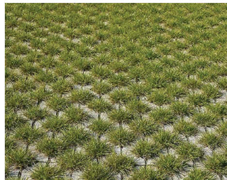
Grasbeton voor waterdoorlaatbaarheid
