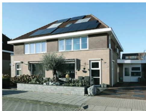
Schilddak met zonnepanelen
