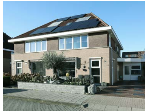
Schilddak met zonnepanelen
