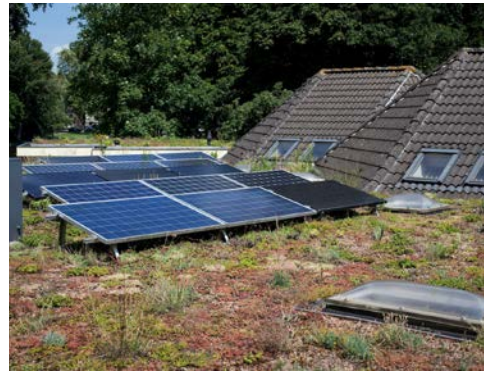
Plat dak met vegetatie en zonnepanelen
