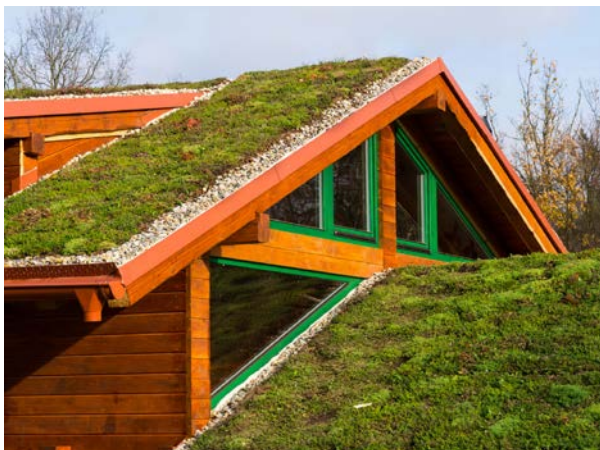
Groene daken voor waterinfiltratie op eigen kavel
