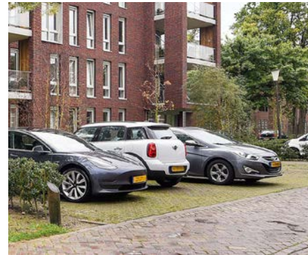
Parkeren op grasbeton
