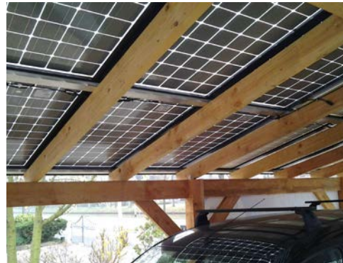
Overkapping met zonnepanelen
