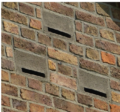
Geïntegreerde nestkasten voor vleermuizen
