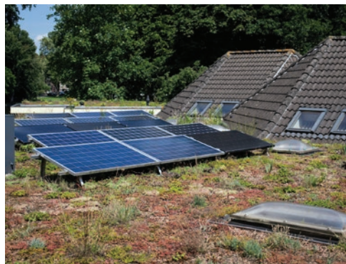
Plat dak met vegetatie en zonnepanelen
