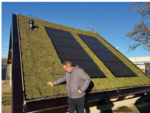
Groen hellend dak met zonnepanelen
