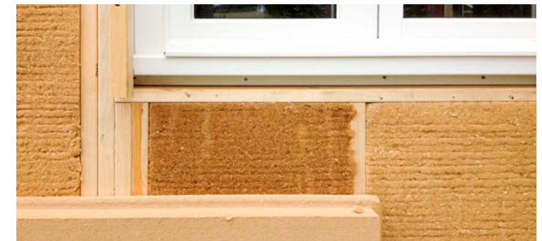
Gevelopbouw met biobased materialen
