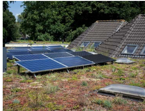
Plat dak met vegetatie en zonnepanelen
