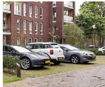
Parkeren op grasbeton
