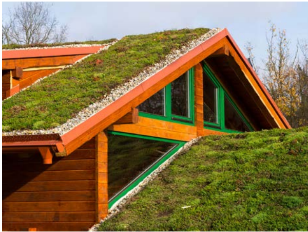
Groene daken voor waterinfiltratie op eigen kavel
