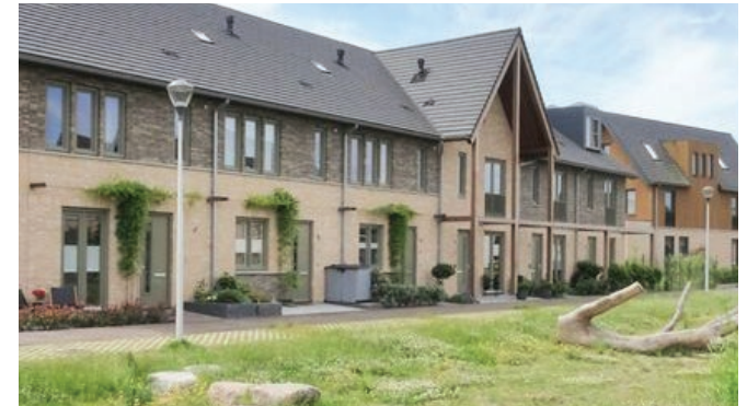
Rijwoning aan het park met goede overgang openbaar privé
