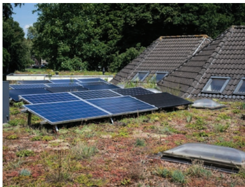
Plat dak met vegetatie en zonnepanelen
