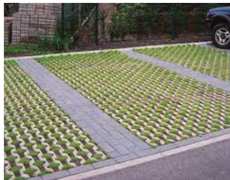
Parkeren op grasbeton
