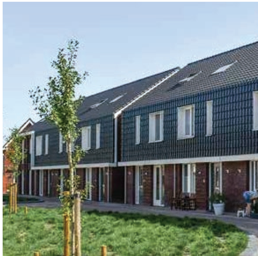
Geveltuin aan het park
