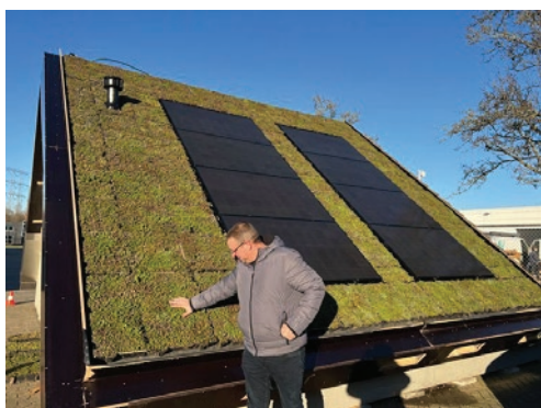
Zonnepanelen op het dak
