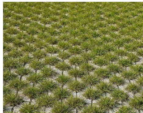
Grasbeton voor waterdoorlaatbaarheid
