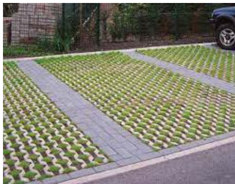
Parkeren op grasbeton
