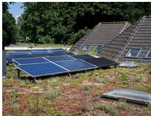
Plat dak met vegetatie en zonnepanelen
