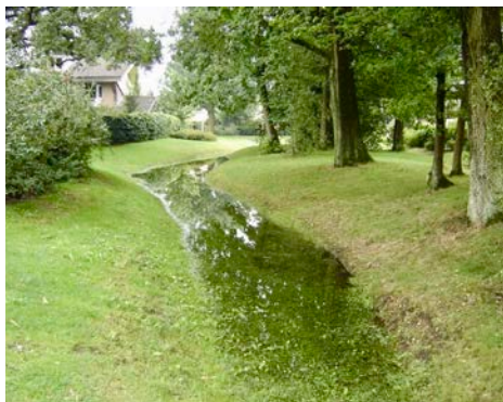
Greppelvormige wadi in reliëf park
