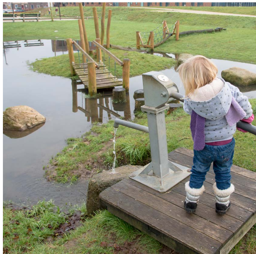
Meervoudig ruimtegebruik: wadi gecombineerd met speelvoorzieningen
