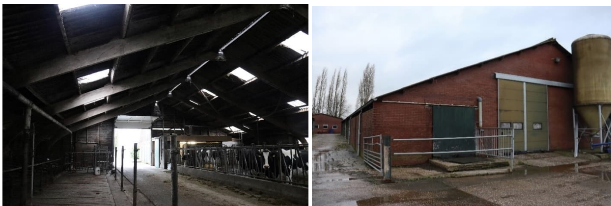
Figuur 3-12 Impressie gebouw 6: links binnen- en rechts buitenaanzicht. Foto's: RHDHV, februari 2022.
