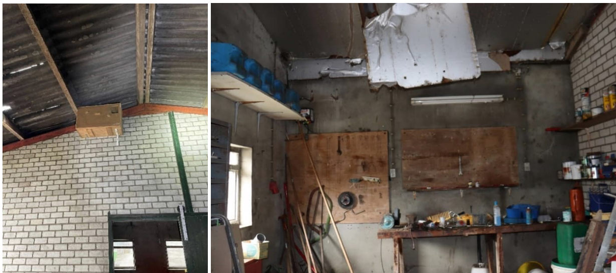
Figuur 3-9 Impressie gebouw 4: met links de kerkuilenkast in nok kapschuur en rechts de werkplaats met los isolatiemateriaal. Foto's: RHDHV, februari 2022.
