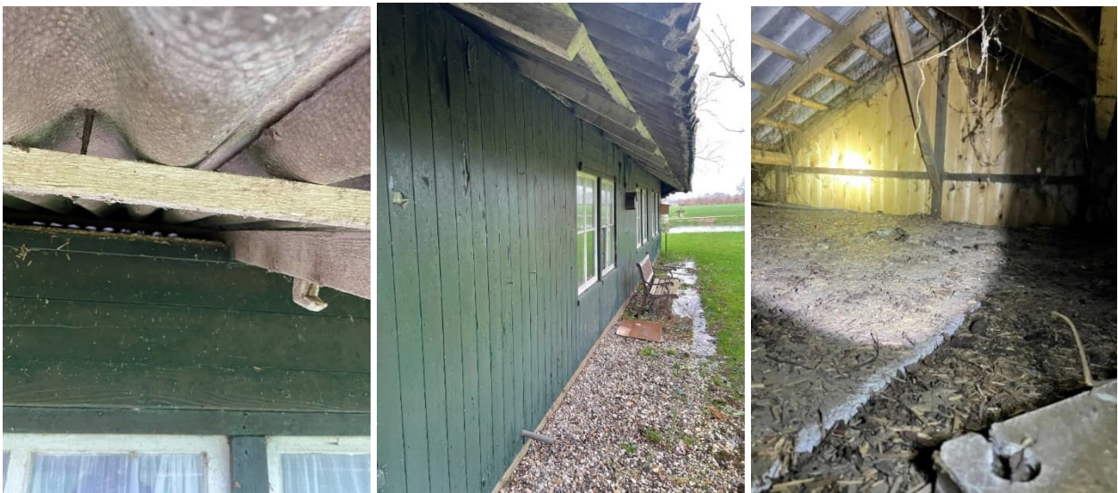
Figuur 3-16 Impressie gebouw 9: links golfplaten dak, midden de buitenkant van de houten wanden en rechts de zolder. Foto's: RHDHV, februari 2022.
