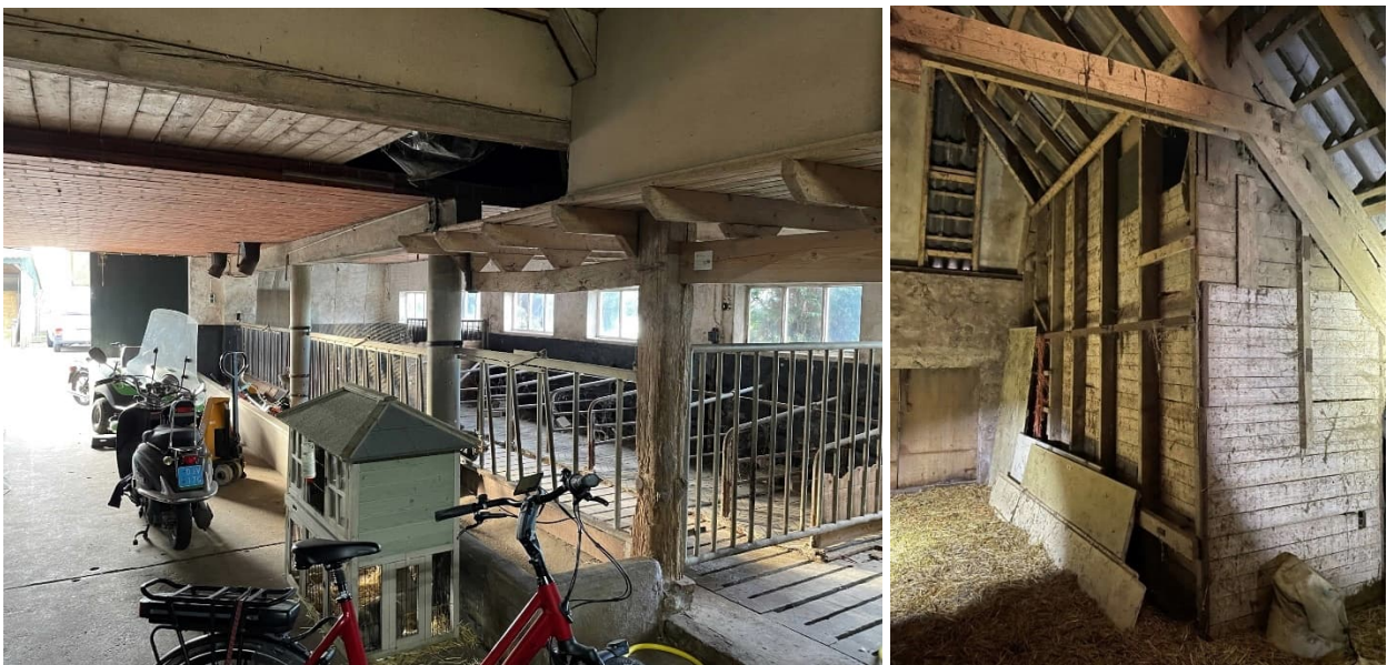
Figuur 3-14 Impressie gebouw 7: links de opslag benedenverdieping en rechts de betimmering op de hooizolder. Foto's: RHDHV, februari 2022.
