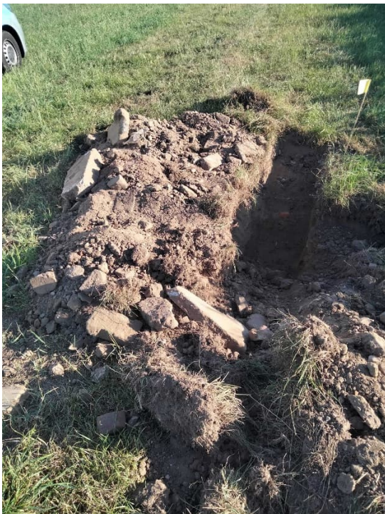
Figuur 10. Foto inspectiegat B035
