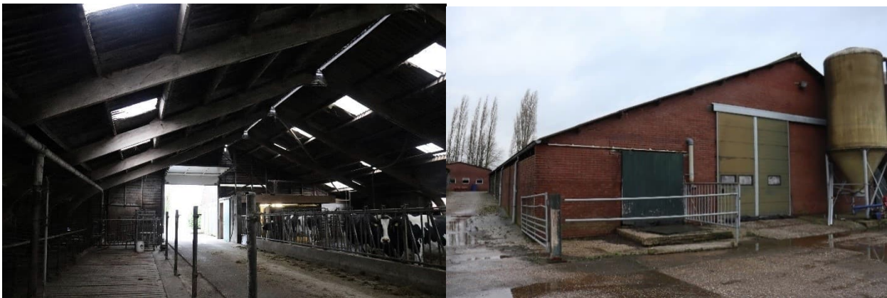
Figuur 2-11 Impressie gebouw 6: links binnen- en rechts buitenaanzicht. Foto's: RHDHV, februari 2022.
