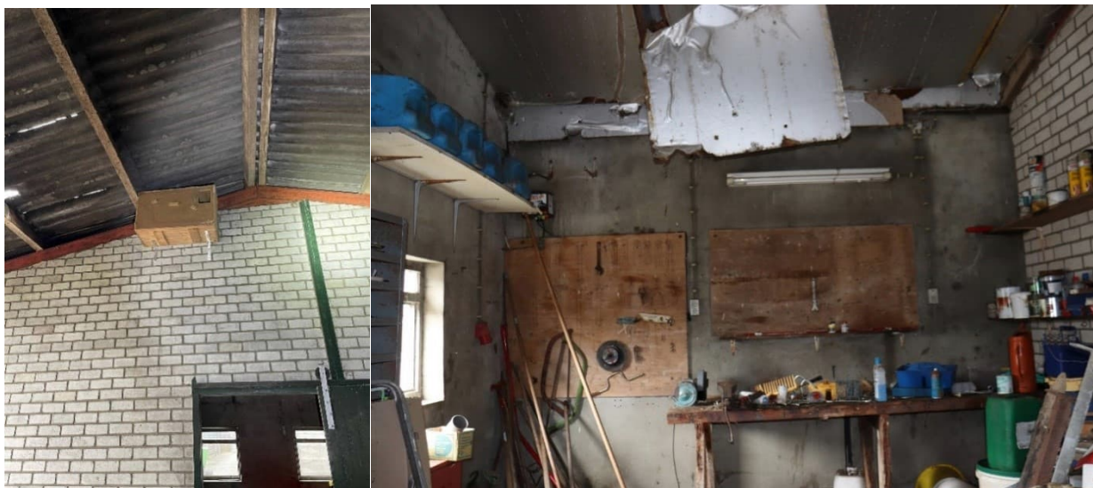
Figuur 2-8 Impressie gebouw 4: met links de kerkuilenkast in nok kapschuur en rechts de werkplaats met los isolatiemateriaal. Foto's: RHDHV, februari 2022.
