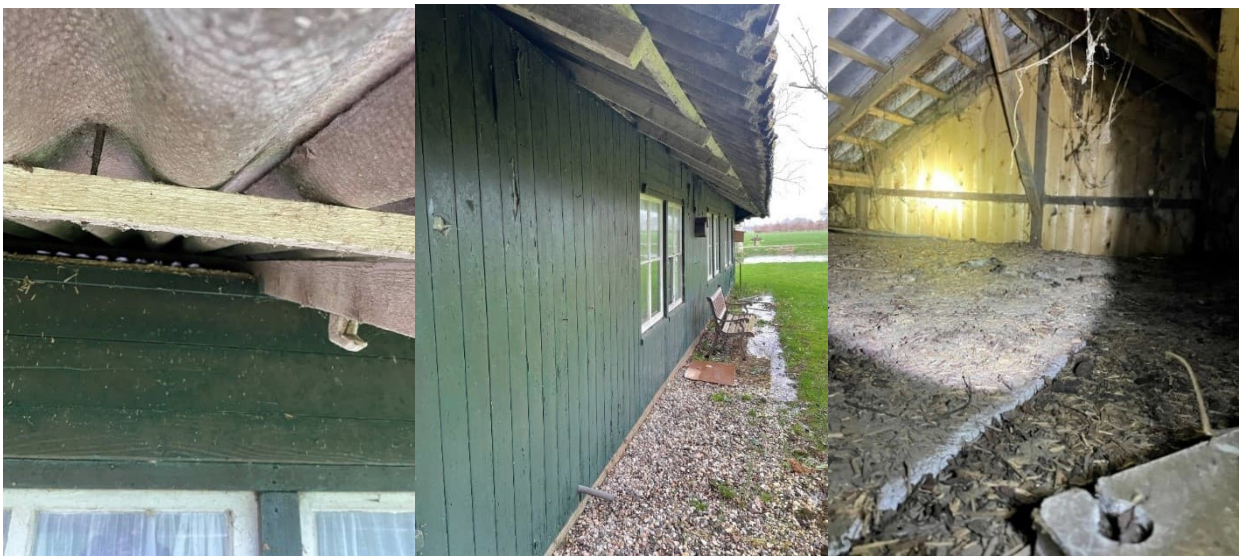
Figuur 2-15 Impressie gebouw 9: links golfplaten dak, midden de buitenkant van de houten wanden en rechts de zolder. Foto's: RHDHV, februari 2022.
