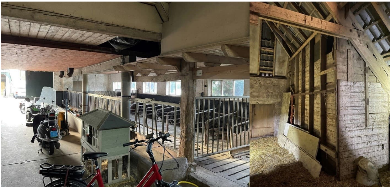
Figuur 2-13: Impressie gebouw 7: links de opslag benedenverdieping en rechts de betimmering op de hooizolder. Foto's: RHDHV, februari 2022.
