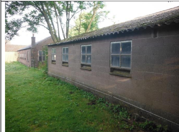
Vanuit oostelijke richting nabij boring 6
