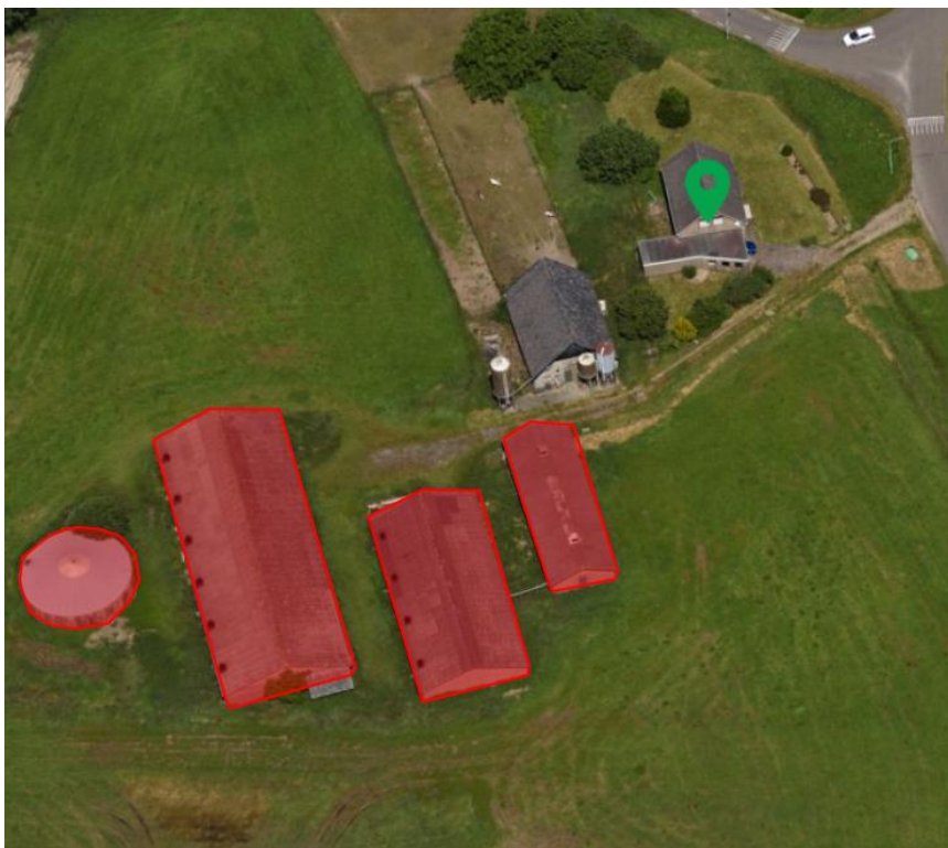
Figuur 18: Obliek Haaghweg 16 met te slopen stallen en mestilo in rood aangeduid
