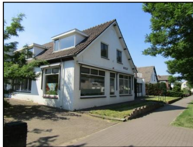
Figuur 4. Zicht op het hotel vanaf de westzijde.
