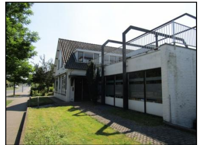
Figuur 5. Zicht op het hotel vanaf de oostzijde.
