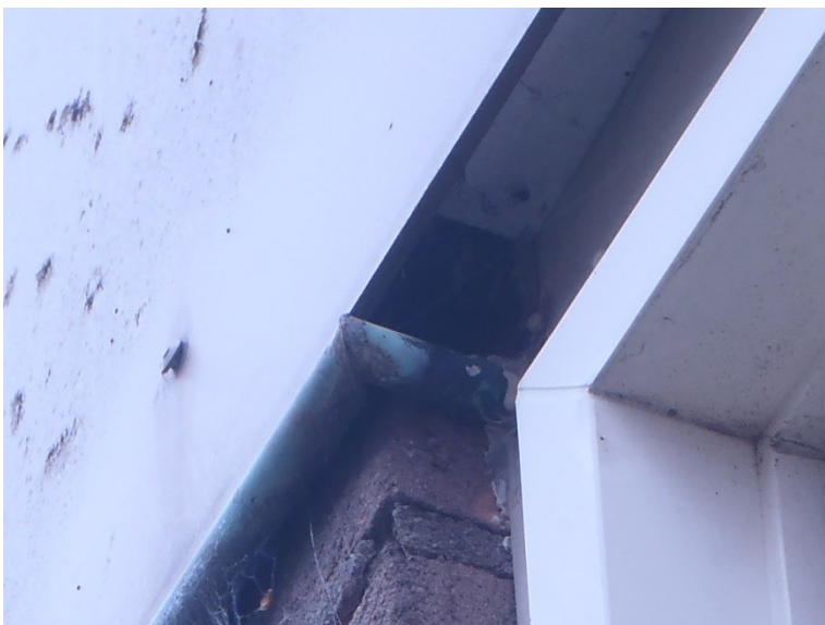
Foto 4: grote opening naast ene kozijn achter de daklijst.
