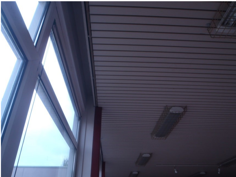
Foto 6: klaslokaal met tussen het plafond en de raampartij. Het is goed te zien dat het plafond niet aansluit op de raampartij. Mogelijk zijn deze plafonds een keer verlaagd aangebracht. Een oude gordijnrail is nog juist zichtbaar.
