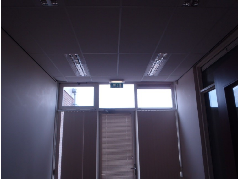
Foto 7: toiletgroep met systeemplafond
