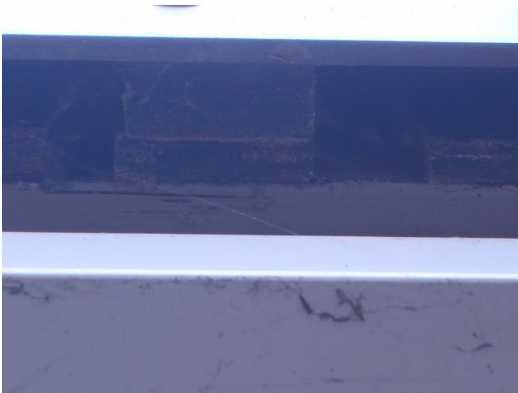
Foto 3: grote openingen achter de dakrand nabij een raamkozijn. Deze ca 3 centimeter grote openingen zijn voldoende voor gewone dwergvleermuizen om in te vliegen.
