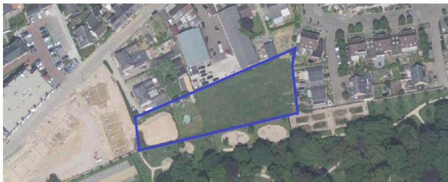
Luchtfoto van het plangebied (voor de bouw van de eerste fase).
