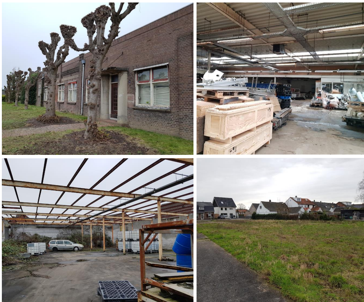
Figuur 2. Impressie van het projectgebied. Linksboven de voorgevel van de bebouwing, rechtsboven de fabriekshal, linksonder de loods zonder dak en rechtsonder het grasveld in het westen van het gebied.
