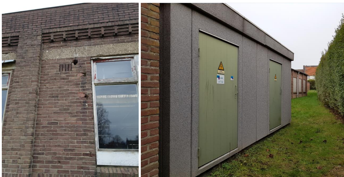
Figuur 6. Openingen in het westelijke deel van het pand die vleermuizen toegang kunnen bieden (links) en het elektriciteitshuisje met de geschikte dakrand (rechts).
