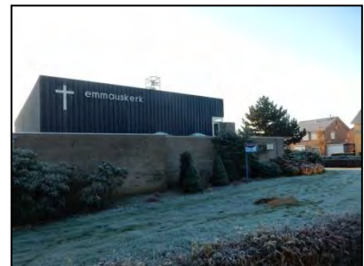
Figuur 5. Achterzijde kerkgebouw.
