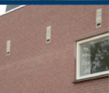
Boven: inbouwen van een verblijfplaats voor vleermuizen
