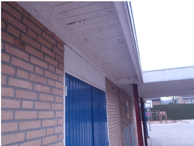
Foto 8: schuur en de overkapping. Het bitumen komt door het dakbeschot heen.
