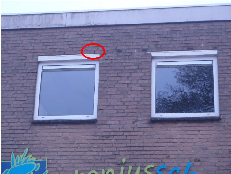
Foto 4: brede open stootvoeg boven het raam in het hoofdgebouw.
