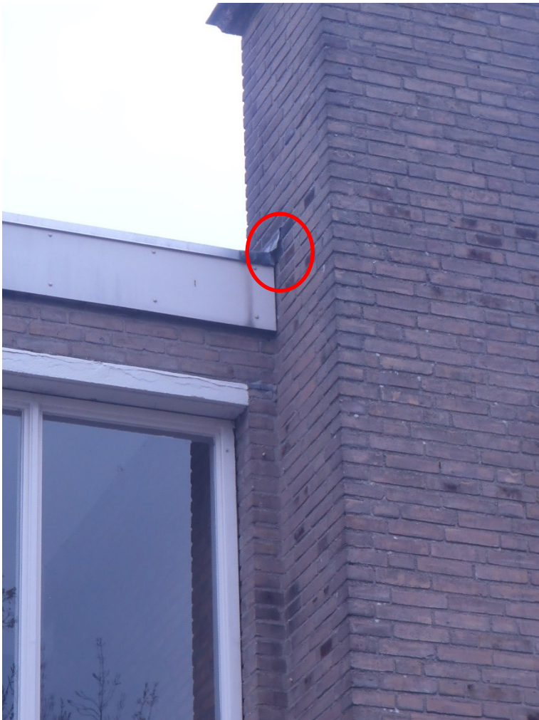
Foto 6: kierende loodslabbe naast de schoorsteen
