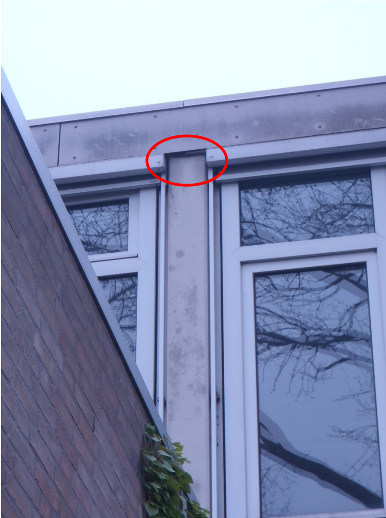
Foto 7: opening achter daklijst bij betonkolom tussen de glaspuien
