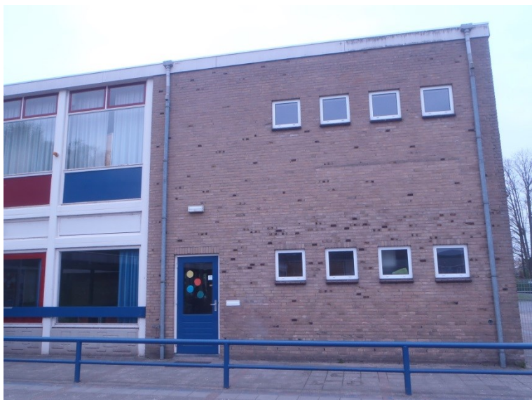
Foto 2: de school aan de noordzijde. Het centrale deel bestaat opnieuw uit glaspuien tussen betonnen kolommen. Aan weerszijden zijn gemetselde muren aanwezig.
