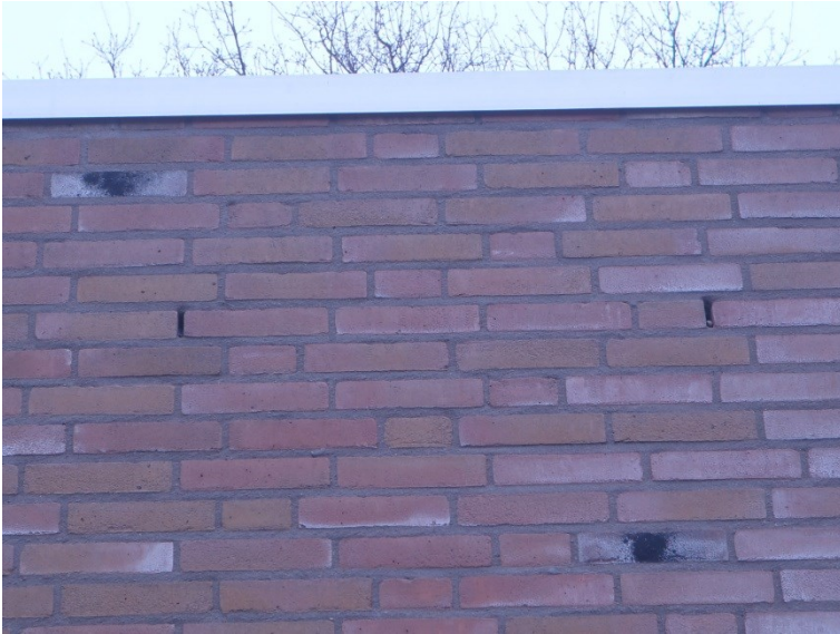
Foto 3: twee open stootvoegen bij de uitbouw aan de zuidzijde van de school. Een aantal van deze stootvoegen zijn breed genoeg voor vleermuizen om in en uit te vliegen.
