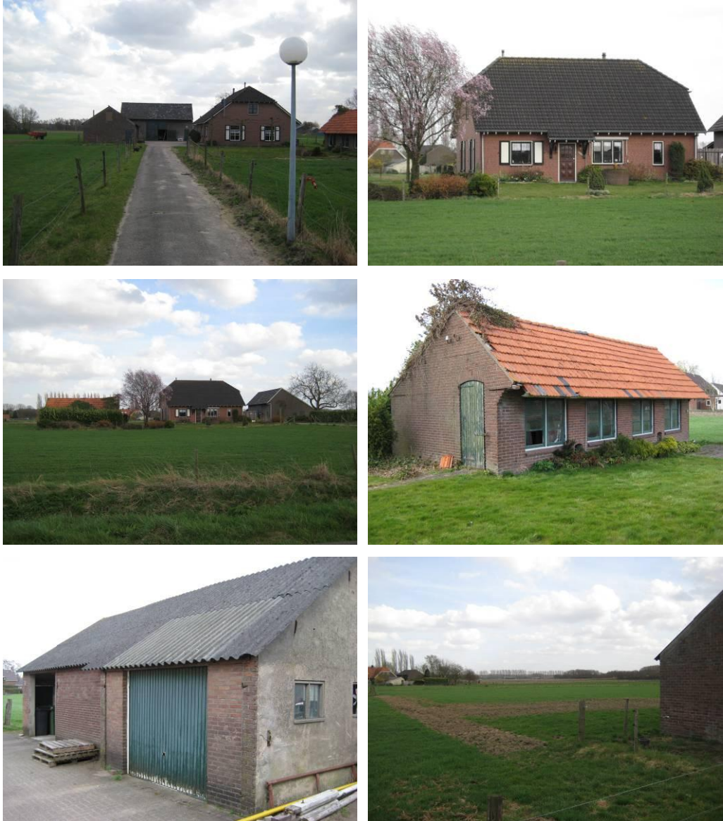
Afbeelding 2: Globale indruk plangebied. Van linksboven naar rechtsonder: het agrarisch bedrijf met de te slopen opstallen, de te behouden woning, het agrarisch bedrijf gezien vanaf de Bosstraat, een te slopen schuur en de te slopen garage.
