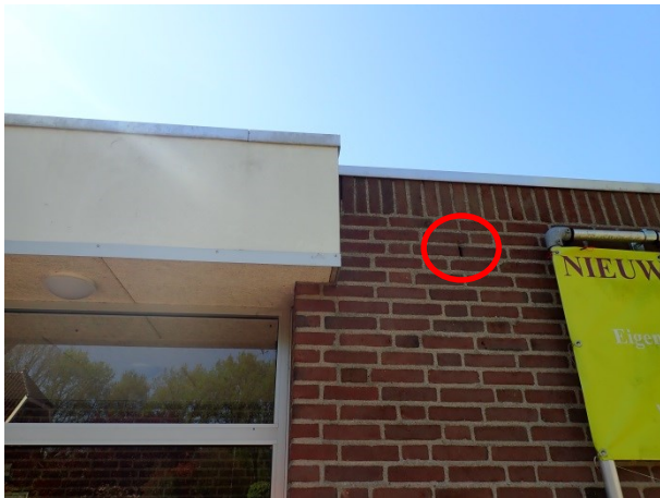
Foto 6: rechts, rollaag aan de zuidzijde van het pand.
